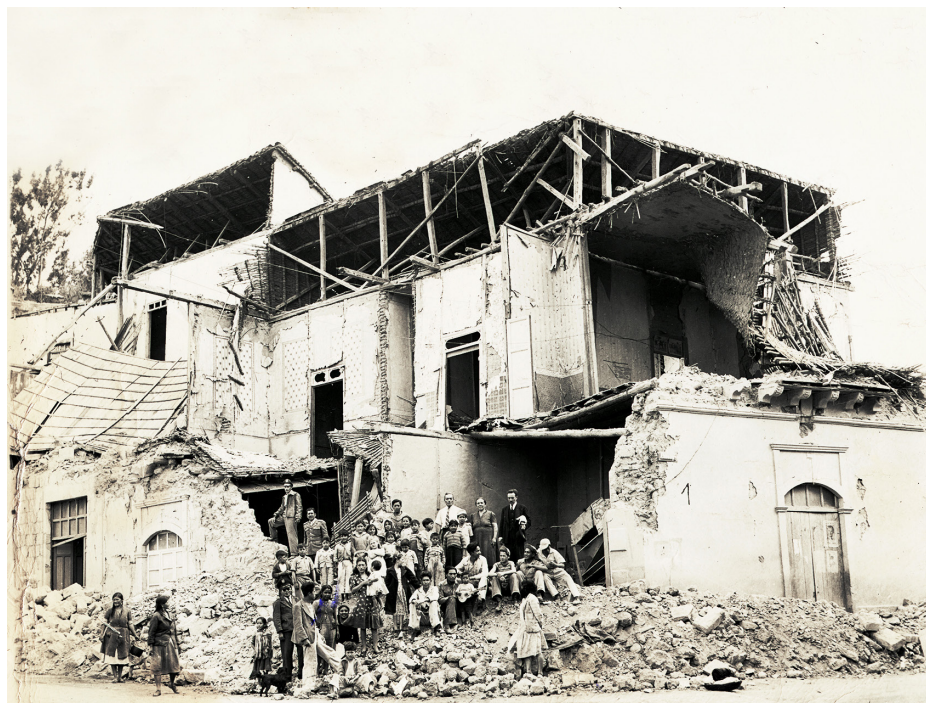
Figura 1. Una casa en la plaza [Urbina] en Ambato. Escuela de Totorá
